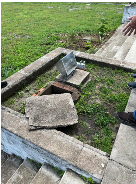
Figura 46: Vista do refletor existente.
