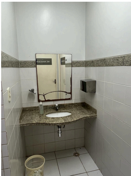
Figura 30: Vista do ralo existente.
