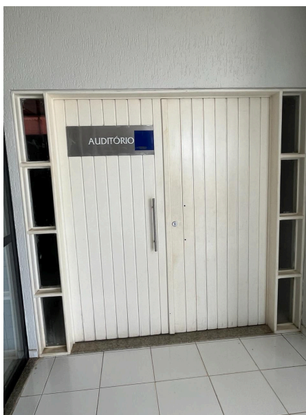
Figura 24: Vista da sinalização atual.
