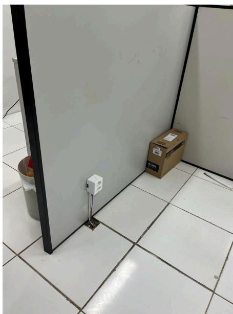
Figura 12: Vista do piso danificado.
