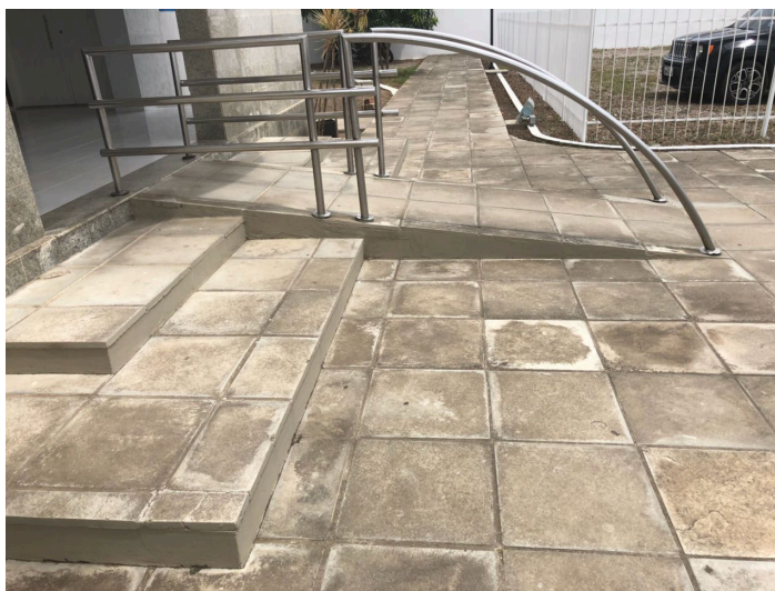
Figura 18: Vista da rampa atual .
