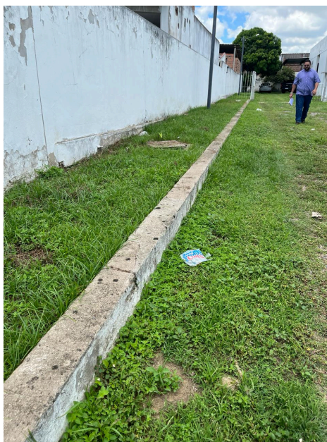
Figura 39: Vista da jardineira.
