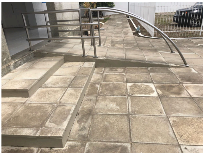
Figura 54: Vista da rampa da entrada do prédio.
