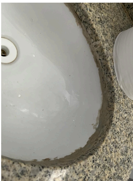
Figura 33: Vista da cuba.
