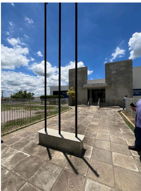
Figura 55: Vista do mastro.
