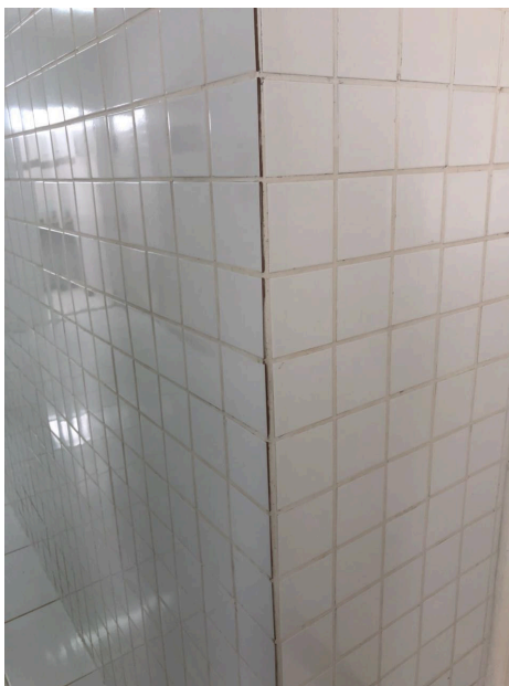
Figura 16: Vista de paredes.
