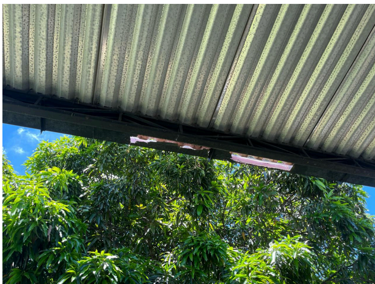
Figura 51: Vista da coberta do estacionamento da viatura.
