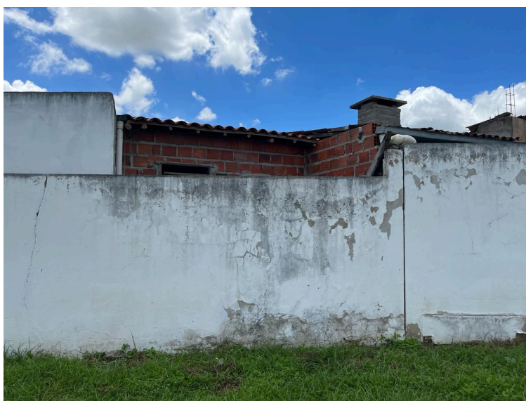
Figuras 40 e 41: Vistas dos muros.
