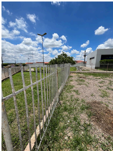
Figura 48: Vista do gradil existente.
