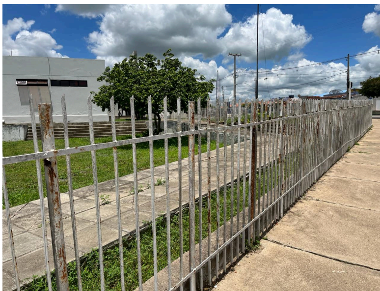
Figura 47: Vista do gradil existente.
