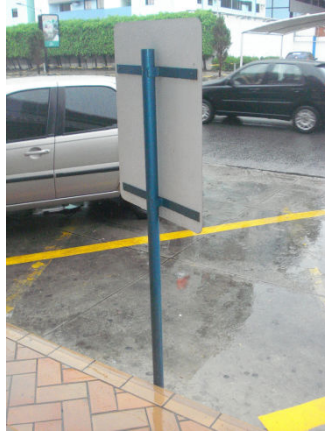
Foto 09 – Placa de estacionamento de coluna.
