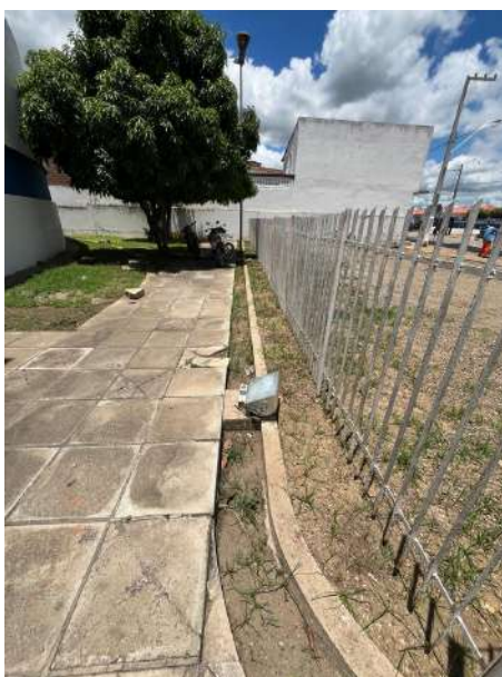
Figura 52: Vista da valeta e passeio interno.
