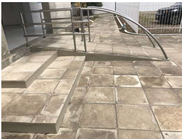
Figura 18: Vista da rampa atual .
