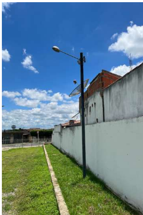
Figura 45: Vista do poste do estacionamento.
