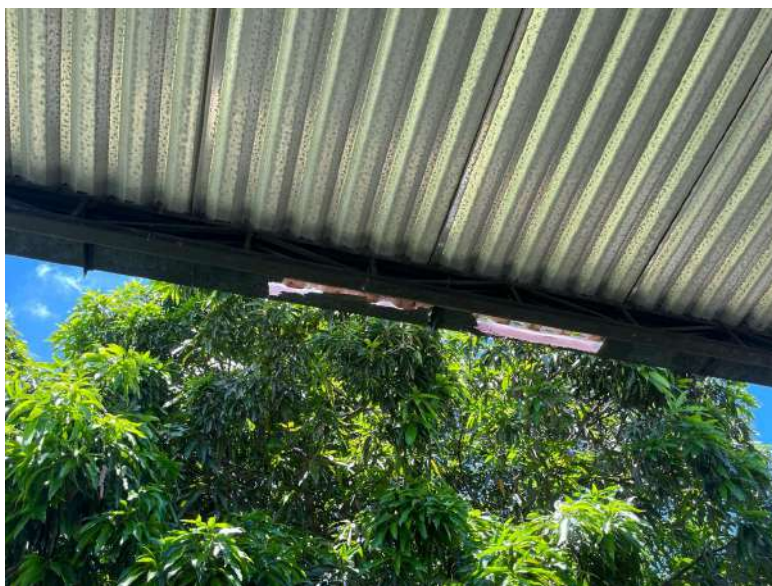
Figura 51: Vista da coberta do estacionamento da viatura.
