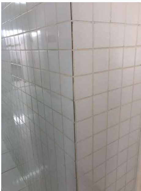
Figura 16: Vista de paredes.
