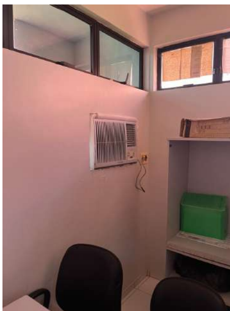
Figura 23: Vista das janelas.
