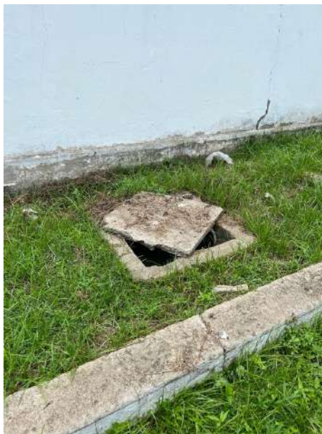
Figura 38: Vista de caixa de passagem.
