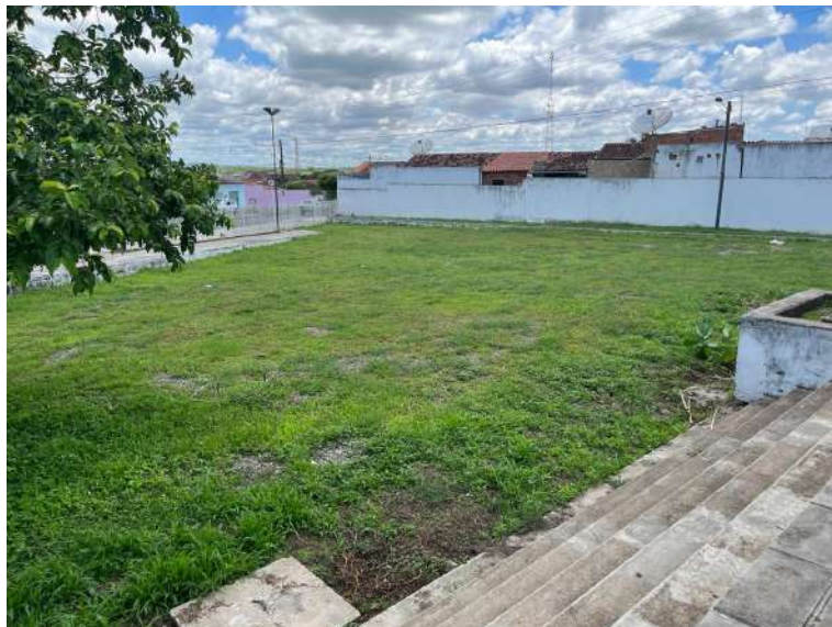
Figura 42: Vista da escadaria.
