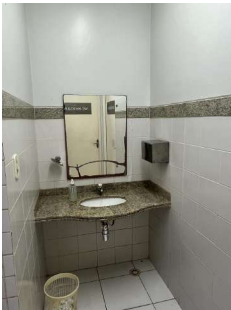
Figura 30: Vista do ralo existente.
