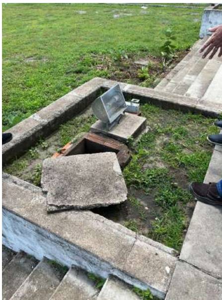
Figura 46: Vista do refletor existente.
