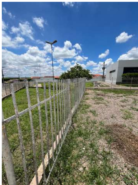
Figura 48: Vista do gradil existente.
