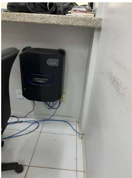
Figura 63: Vista da central técnica.
