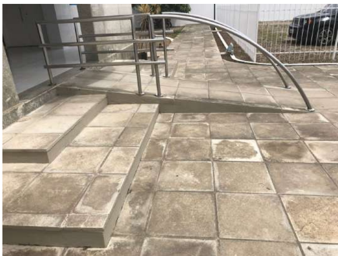
Figura 54: Vista da rampa da entrada do prédio.
