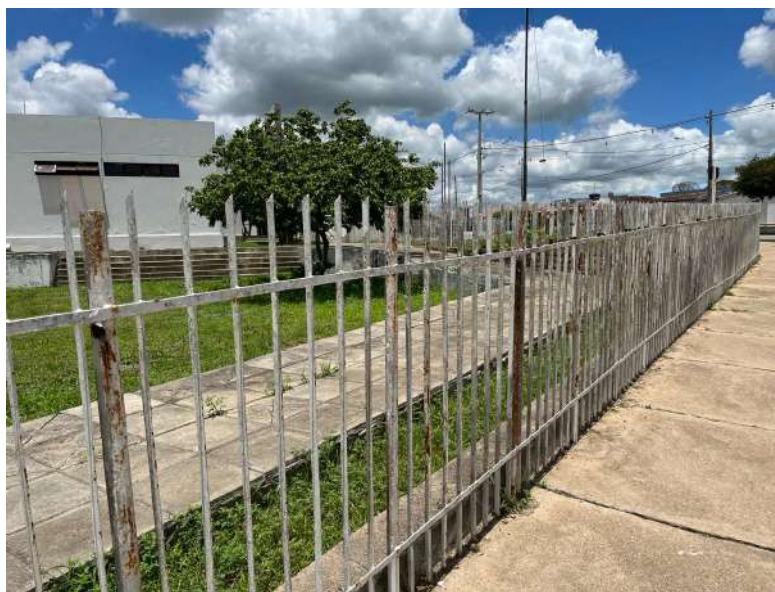
Figura 47: Vista do gradil existente.
