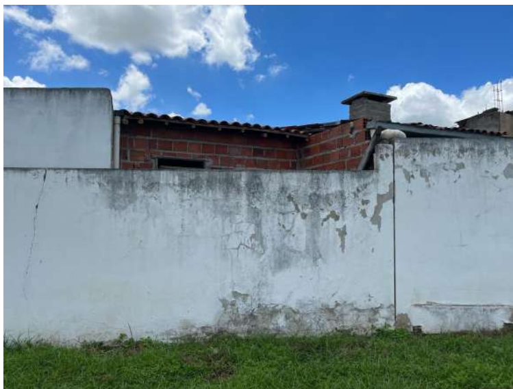
Figuras 40 e 41: Vistas dos muros.
