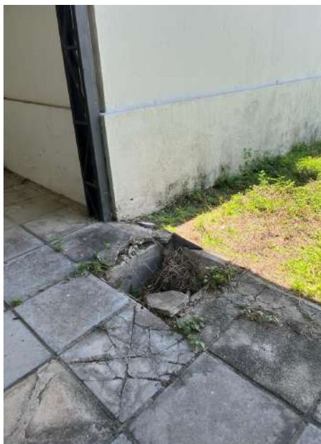
Figura 49: Vista do piso do estacionamento da viatura.
