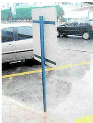
Foto 07 – Modelo da barra chata para sustentação da placa.
